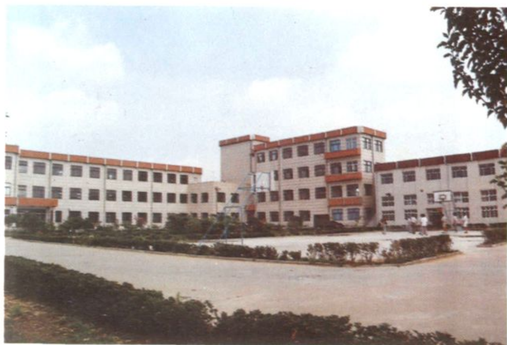
党校的教学、办公及学员宿舍大楼
