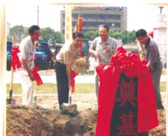
荆门市领导李宗轩、胡才兴和荆门市石化总厂领导郑国华、朱德启为医院新门诊楼奠基
