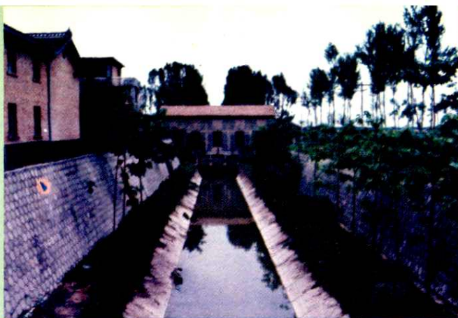
交口抽渭北干渠左家抽水站
