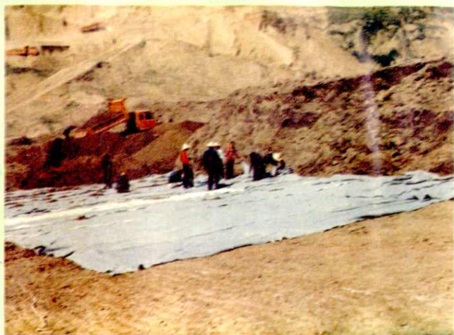
西王水库土工织物坝体施工
