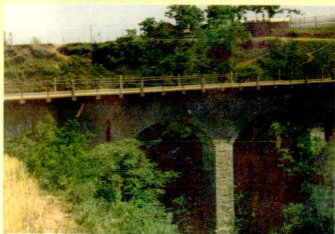
桥南东沟渡槽
