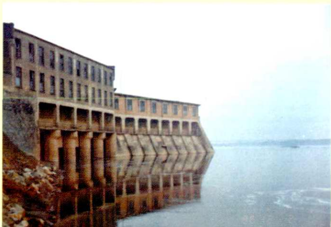
交口抽渭西楼站进水闸
