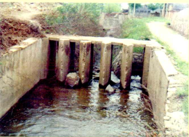
箭峪水库渭华两县分水闸
