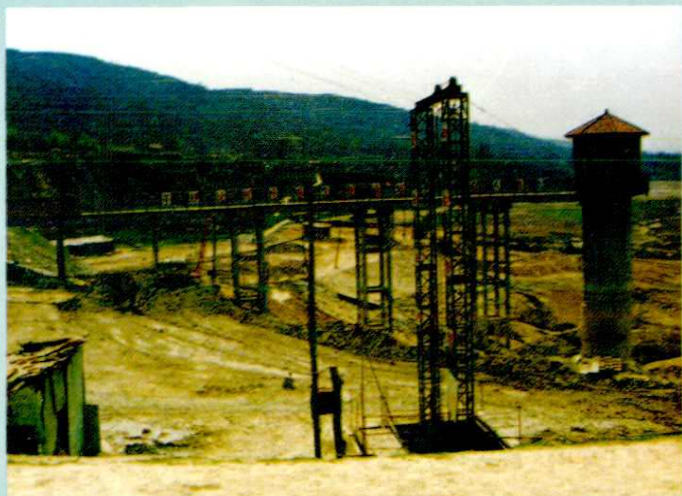
潜河水库改造工程施工
