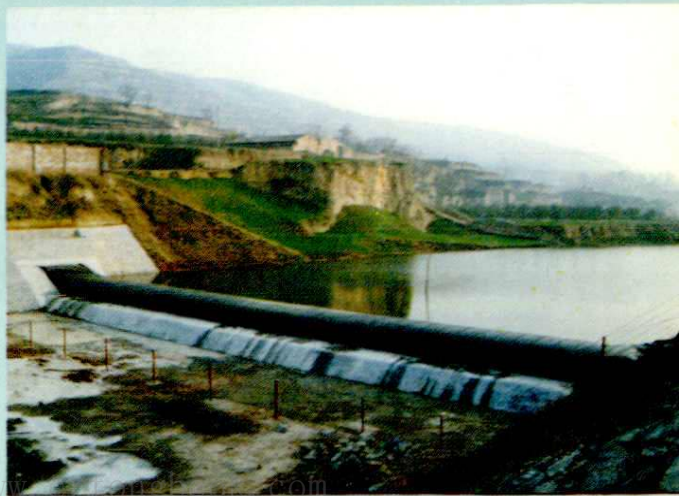
潜河水库溢洪道橡胶坝
