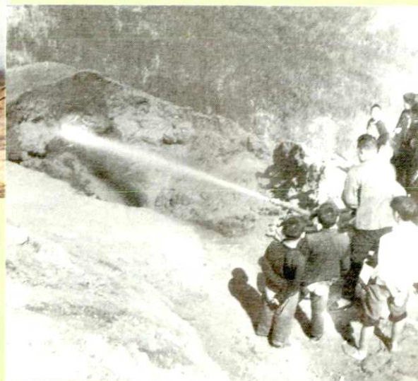
水枪冲土筑坝
