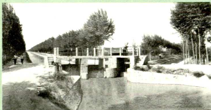
交口抽渭南干渠分水闸
