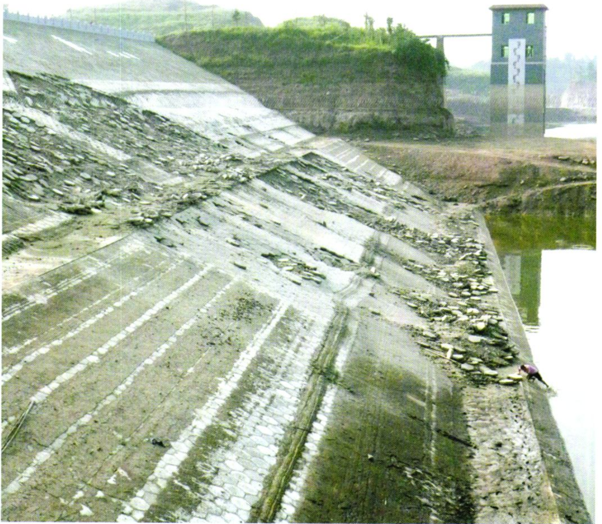
“5.12”（2008年）地震后黑龙幽水库大坝现状
