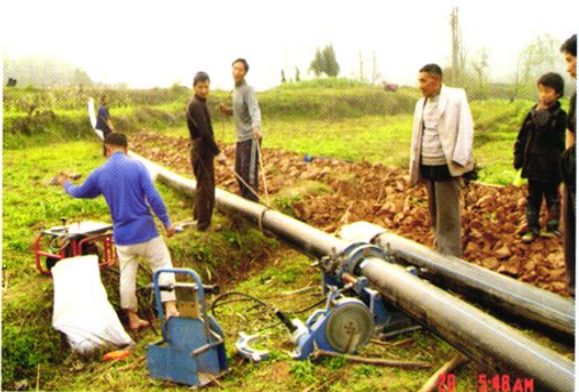
焊接PE塑管,将高升一、二水库毛公滩自来水供水站输水至任隆、三凤
