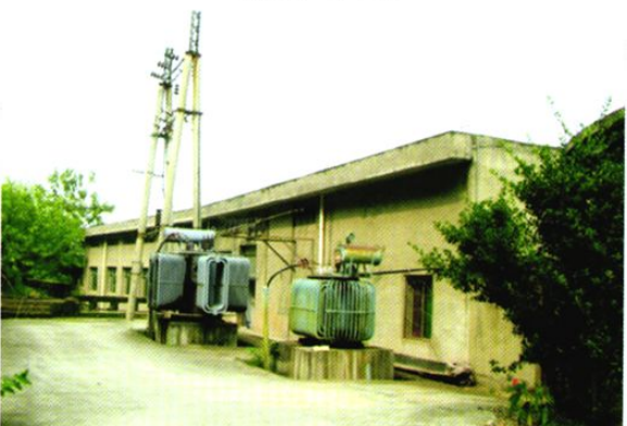
涪引工程1级站
