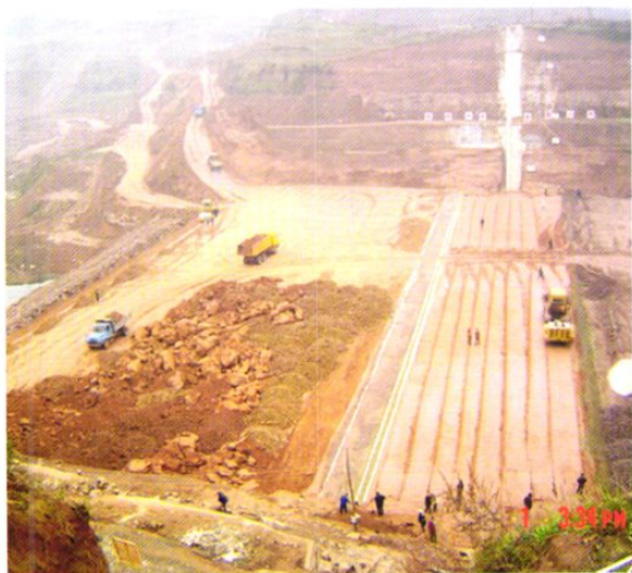
黑龙江水库施工中的水库大坝
