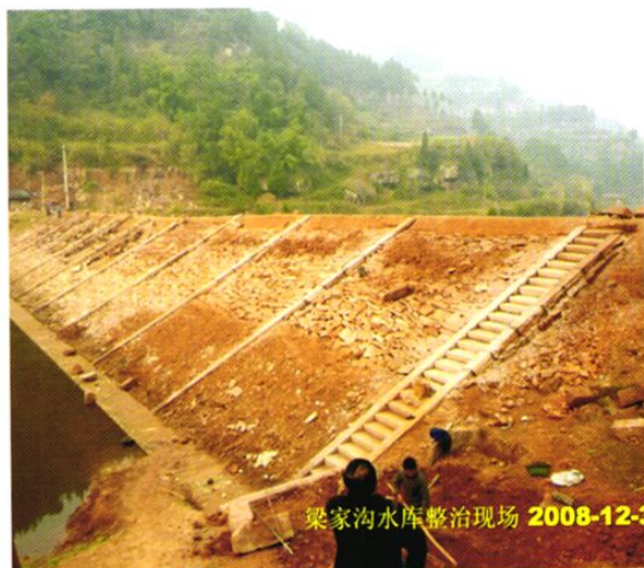
梁家沟水库前坡整治
