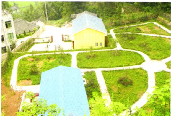
高升一、二水库毛公滩自来水供水站外景
