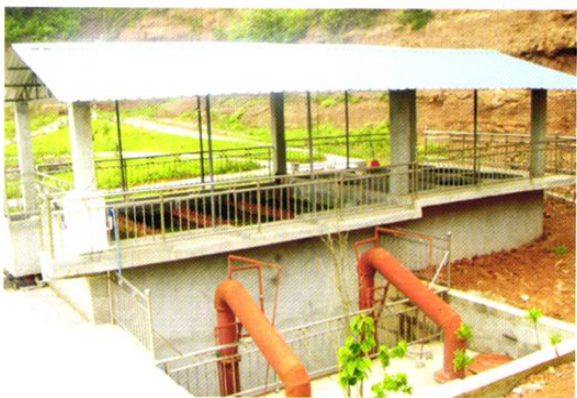
高升水厂净化池
