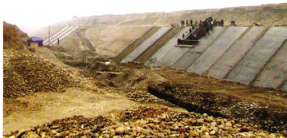
金桥工业港堤防建设
