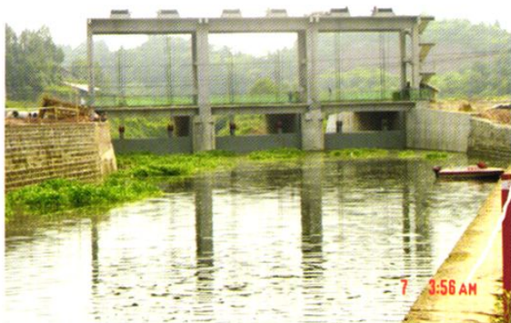
治理中城河段沉浮桥闸门
