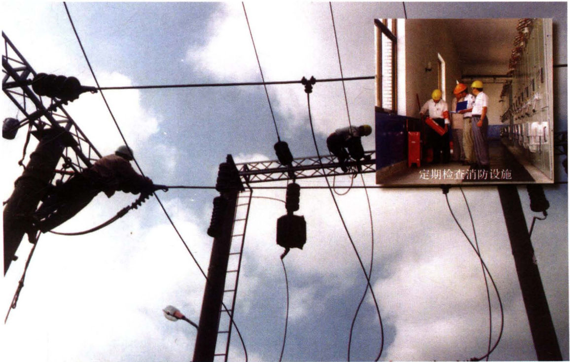
变电所检修现场
