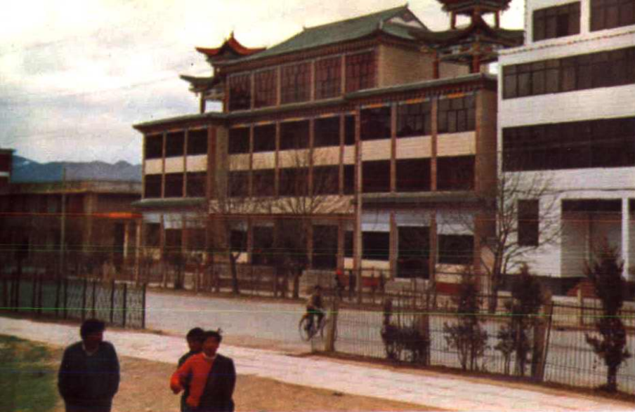
州商业局办公 大楼，下层为民贸 门市部。
