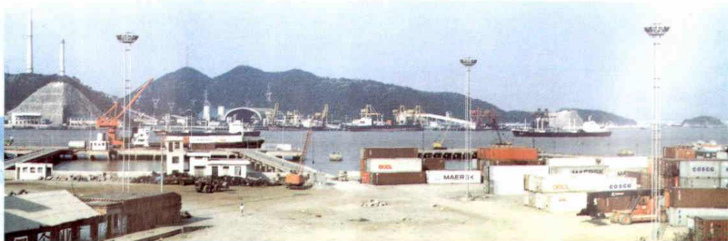
浙江第二大港——海门港外贸港区
