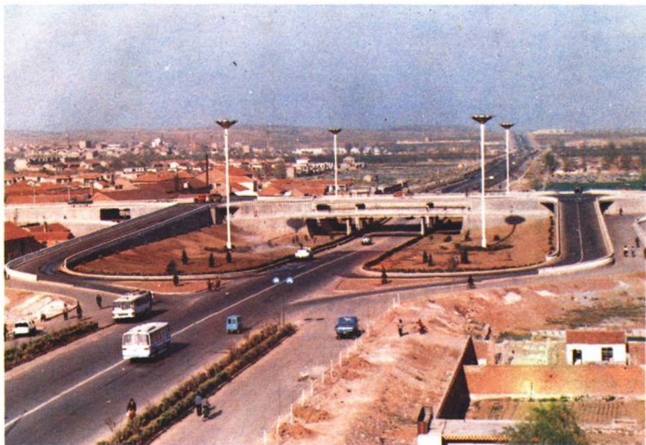
烟青一级公路莱阳立交桥
