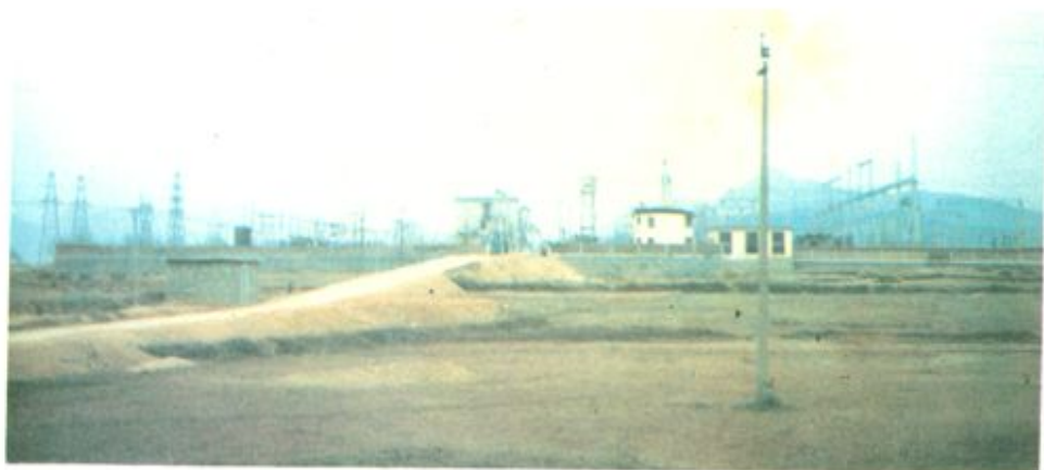
△桂林 220 千伏嵗村变电站
