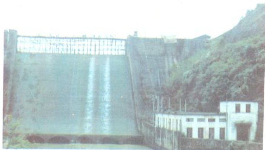
▷ 古信水库大坝、电站
