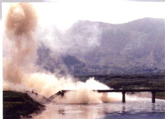
实施库底清理，原天隆大桥被爆破拆除
