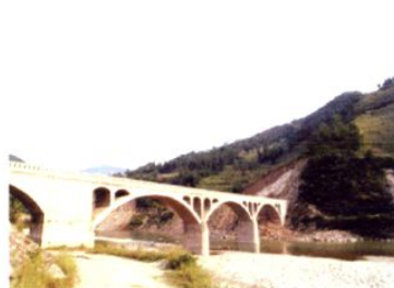
新建骑马银子坝大桥
