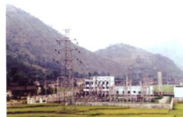
新建木鱼110千伏变电站
