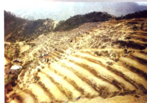
库区改田造地
