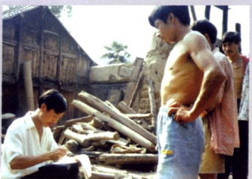
工作人员现场检查拆旧房情况并出具证明
