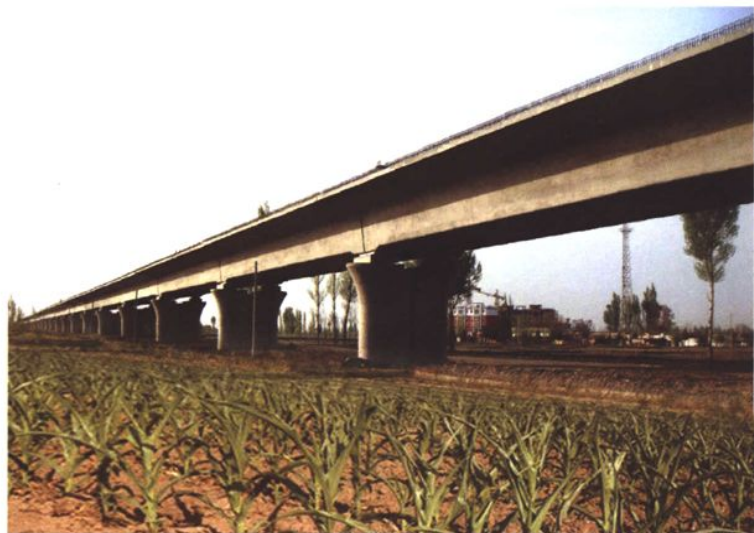
横贯村域的兰新高速铁路
