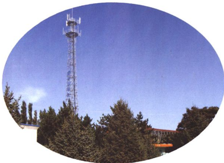
村域内移动通信公司发射塔
