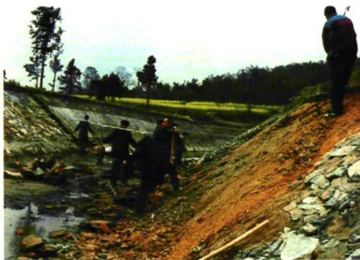
◁ 2000年，金檀灌区续建配套工程开工。图为渠道护坡防渗施工情形
