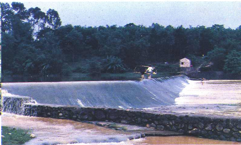
罗旺引水渠拦河坝
