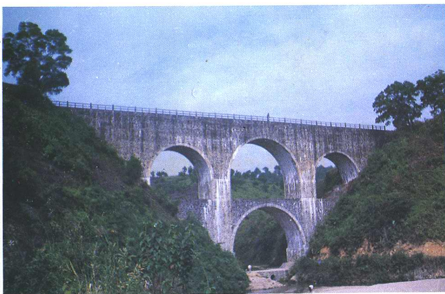
木根河水利工程中和引水渠大渡槽(杨树砭摄)
