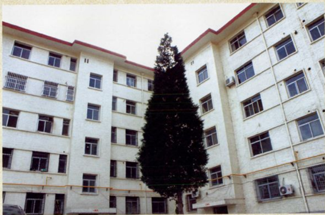
延安市审计局职工住宅3号楼
