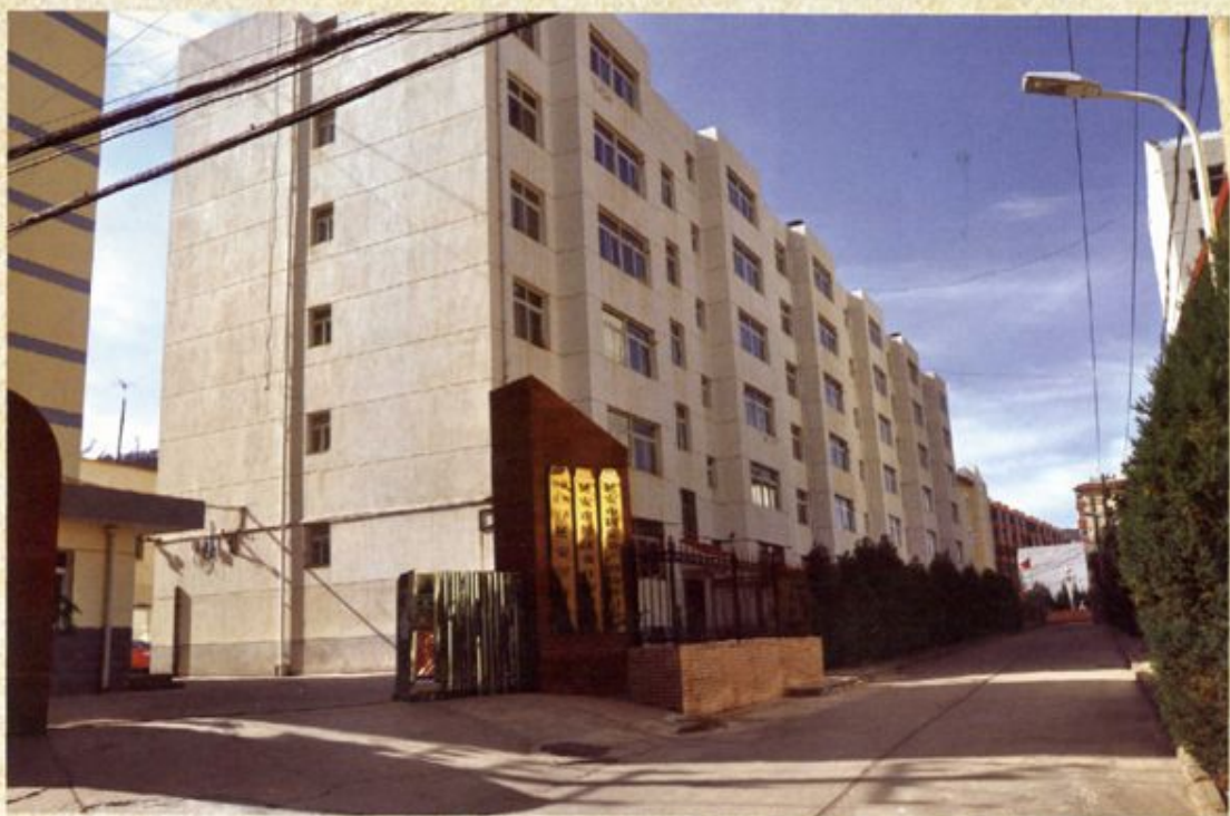
延安市审计局职工住宅2号楼
