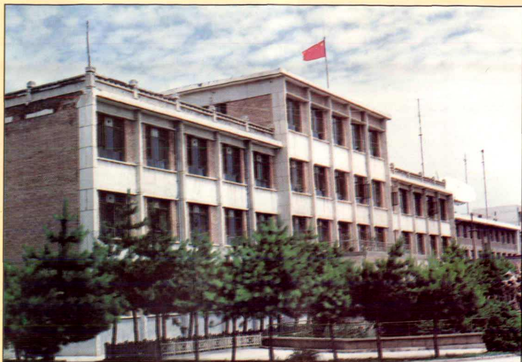
县人民政府办公楼
