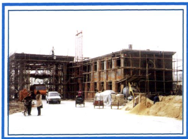
正在施工中的老港海关卡门
