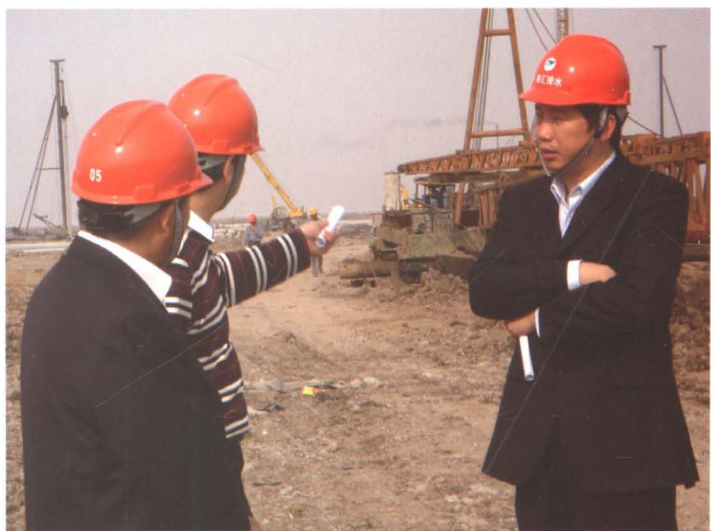
2007年4月26日，局长李春铭（右一）视察污水纳管工程。
