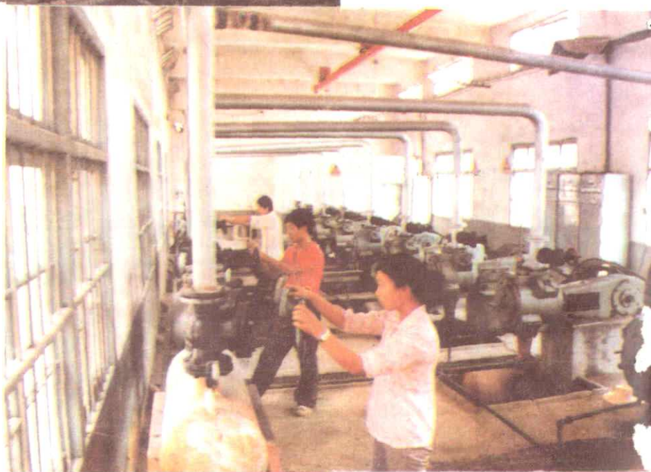
▶钛白粉车间风机工段
