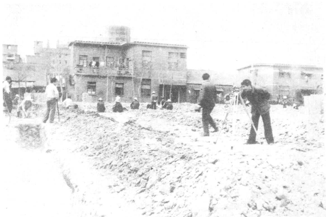
▲钦白粉工程放线测量
