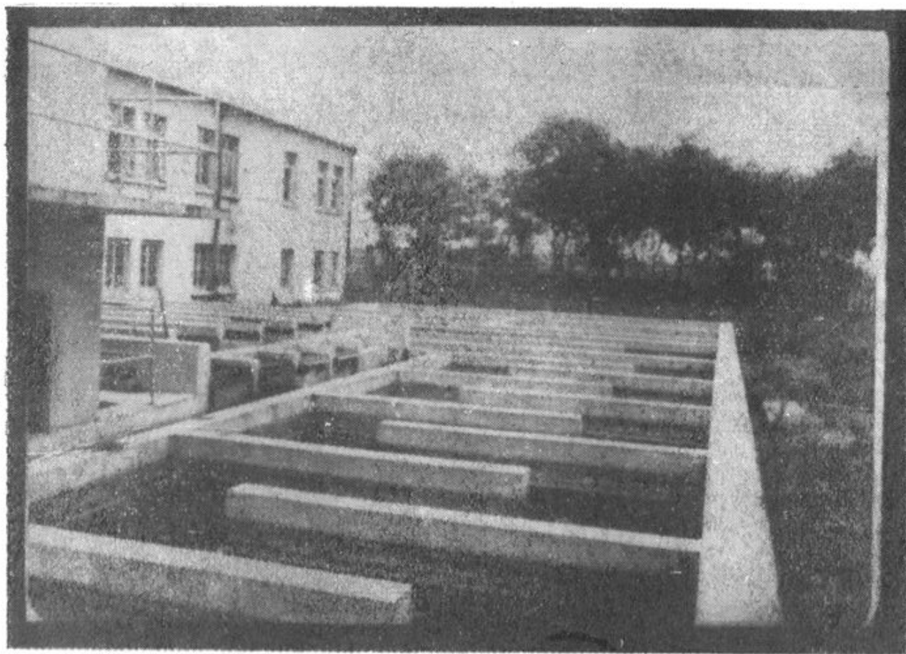
武进毛纺厂污水处理站
