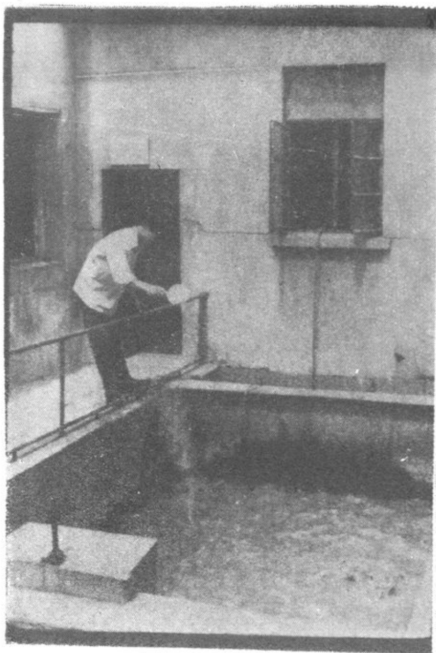
武进轻工电镀厂污水处理站
