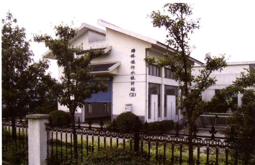
塘桥镇污水提升站(2010年摄)
