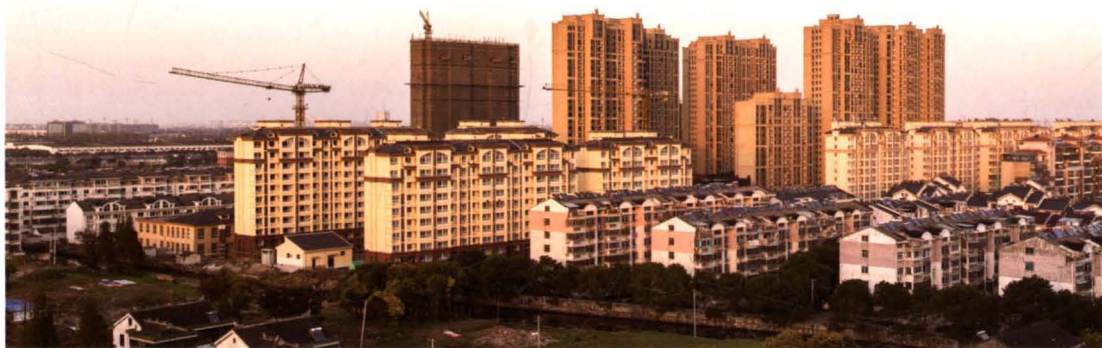
塘桥镇新建高层住宅(2016年摄)
