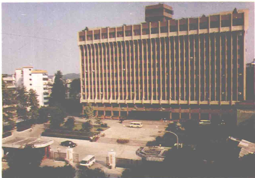
▷ 中共韶关市委办公大楼位于薰风路，楼高三十三层，总面积为12256平方米。由韶关市第二建筑工程公司（省级先进企业）承建。
