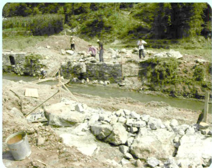
在建的千丝营村石拱桥
