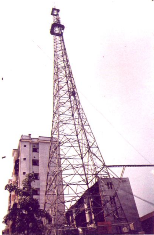
► 右图为移动电话基站铁塔。
