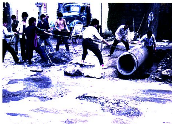
铺设过街排污水泥管道
