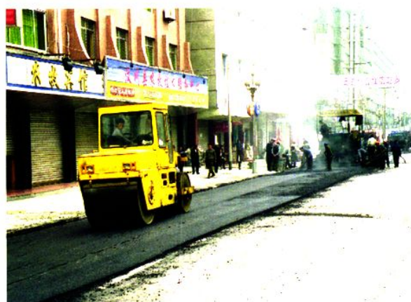
油路队正在铺设东街油路
