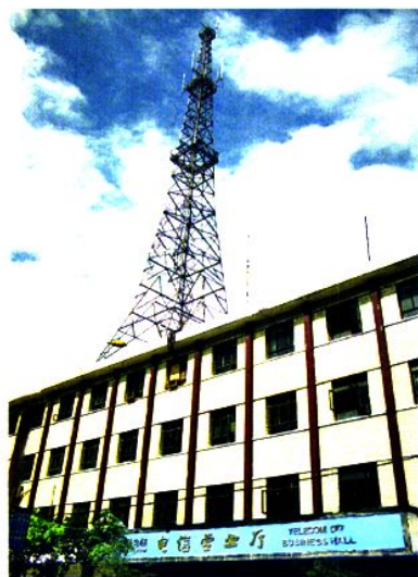
县电信营业大楼
