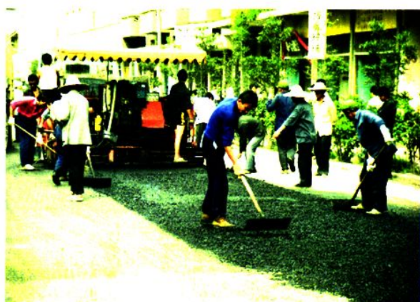
铺设柏油路面
