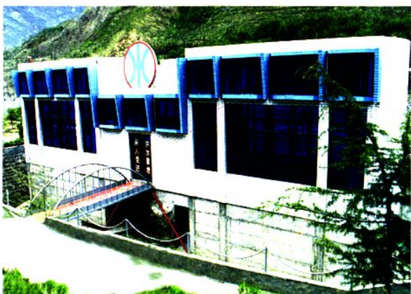
县自来水二厂抽水房（建于1996年）
