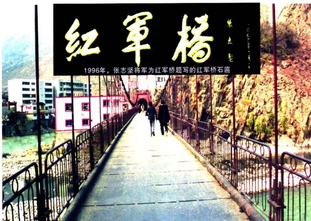
改造后的红军桥（索塔架钢绳吊桥、建于1988年）
