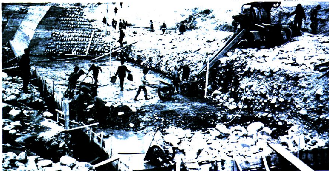
修建中的86.1防洪大堤
