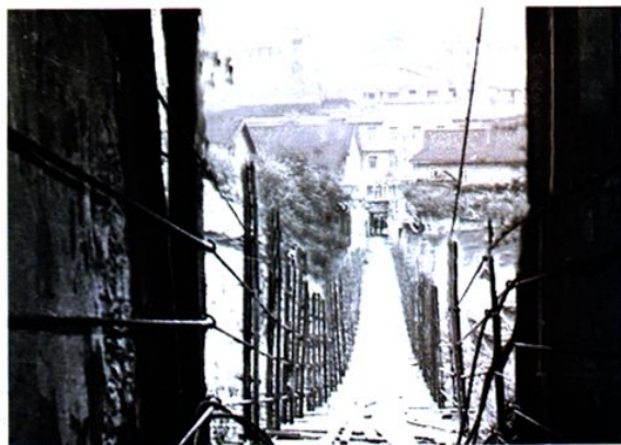
红军桥旧貌（钢绳木板吊桥、建于1955年）
