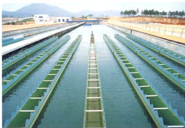
惠阳水厂平流池
