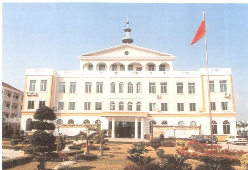
高速公路沙田交警指挥中心(省优良样板工程)
