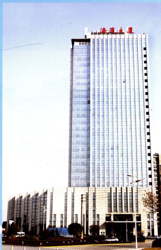
海通大厦位于江宁开发区秦淮路 100 号
