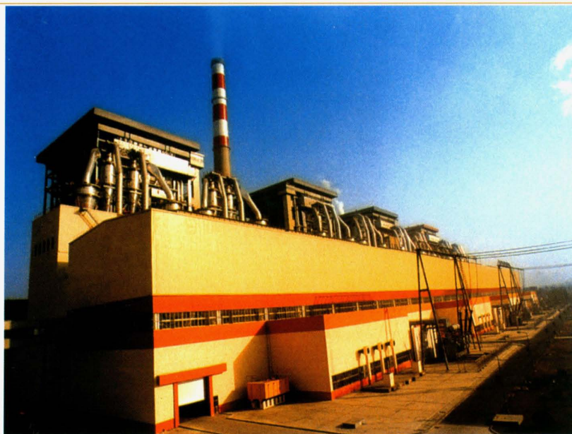
↑ 4 × 335MW 机组外景
