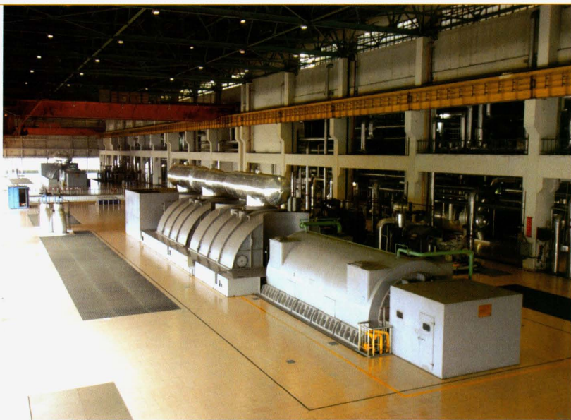
↑ 2 × 600MW 汽轮发电机组
