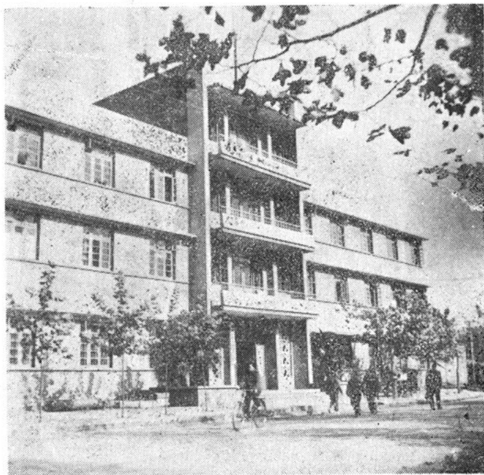
宜城县基本建设委员会办公楼
