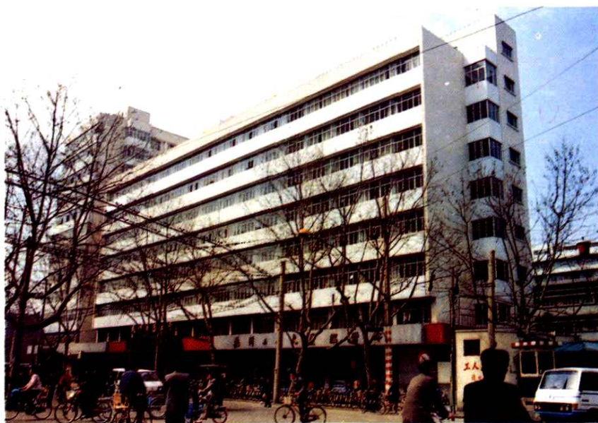
杭州市职工技协现在办公处(市总工会大楼内)。
