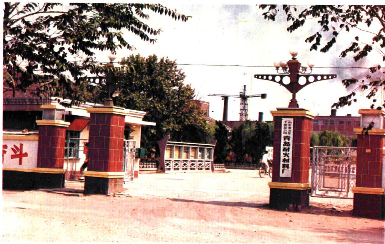
青島耐火材料廠大門
