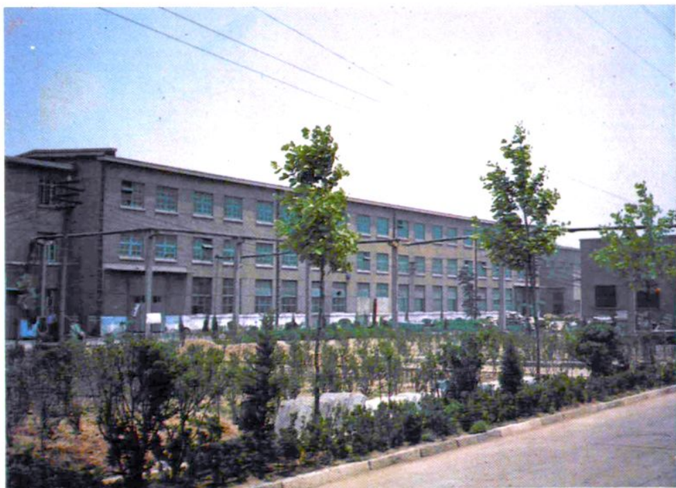
青耐特种耐火材料厂房外景
