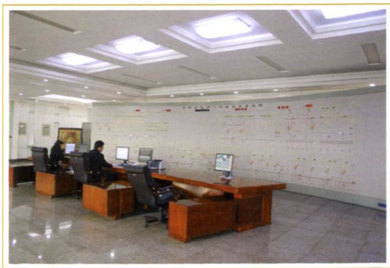
汾阳市电力调度中心
