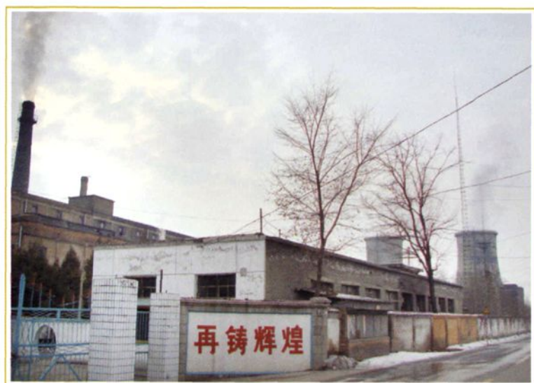
2005年，临县发电厂
