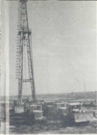
水井钻机整体搬迁
