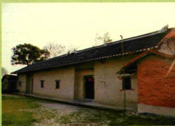
70年代的土墙瓦房民居（2007年摄）
