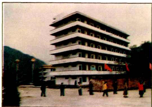
△观音溪水泥厂综合楼
