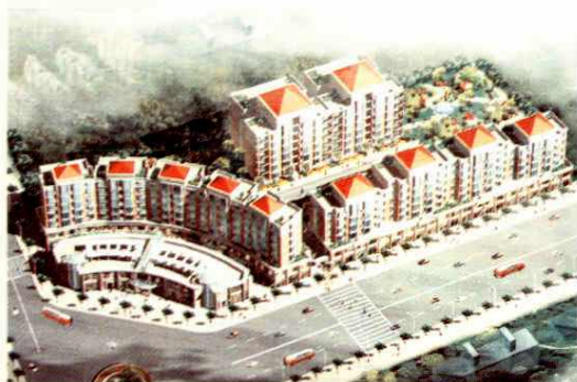
正在建设中的小弯小区
