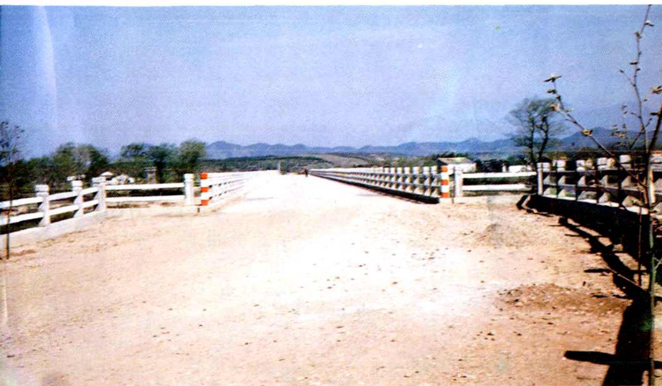
淤头公路大桥
