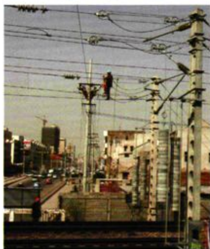
市区配电线路跨越京沪电气 化铁路架线施工
