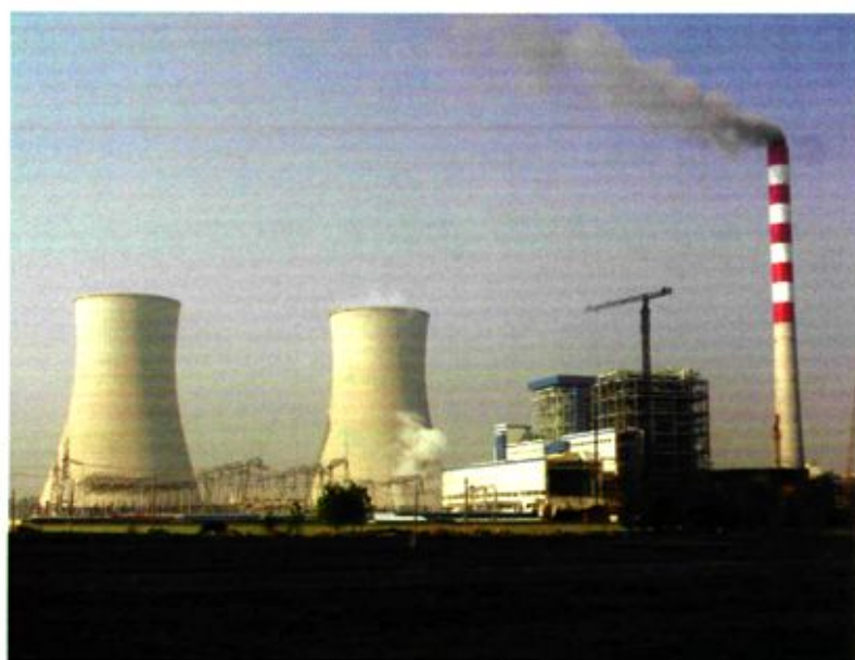
安徽华电宿州电厂 (一期工程2台60万千瓦发 电机组, 2005年5月28日 开工建设, 2007年9月2日 1号机组投产)
