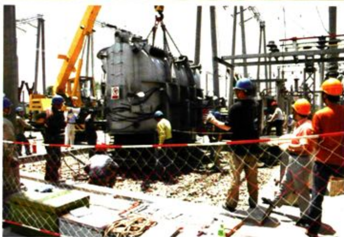
变电所主变压器检修
