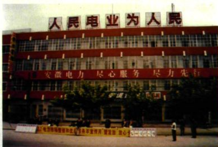
砀山供电公司办公楼
