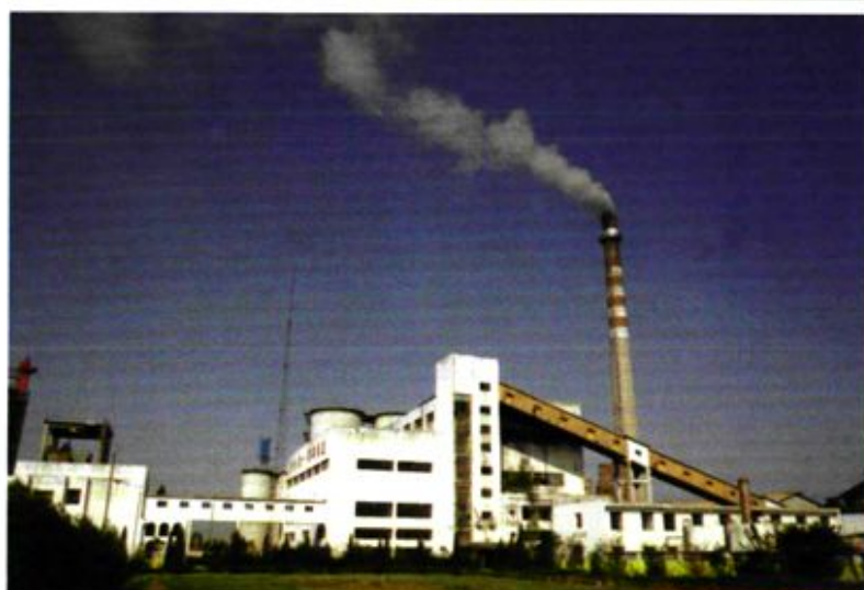
宿州朱仙庄煤研石 发电厂(2台6000千瓦发 电机组)
