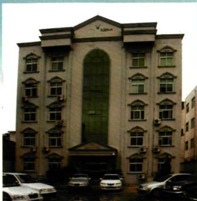
宿州农电公司办公楼
