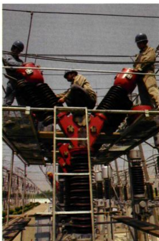
变电所断路器检修
