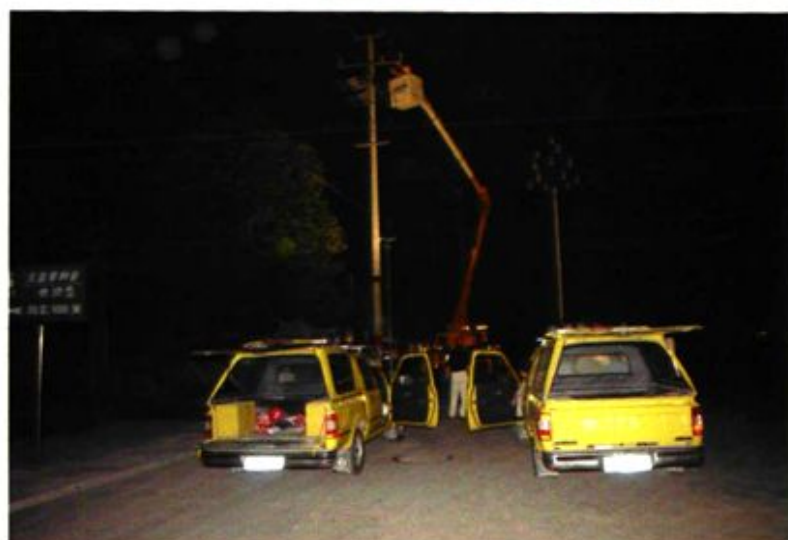
宿城配网夜间带电 抢修
