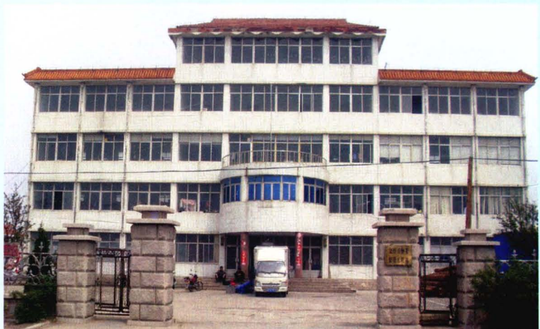
盐业建筑工程处办公楼
