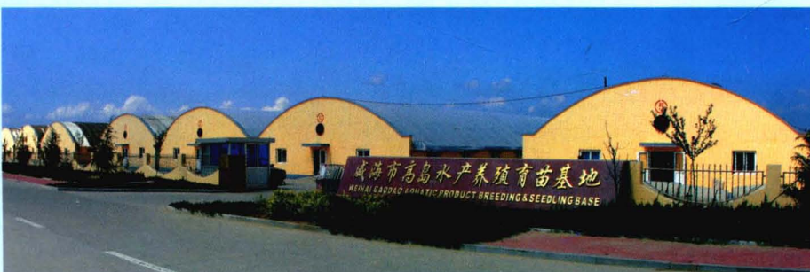
高岛盐场食盐厂门景
