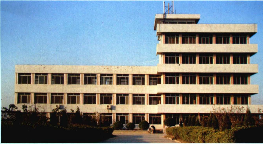
华山盐场办公楼
