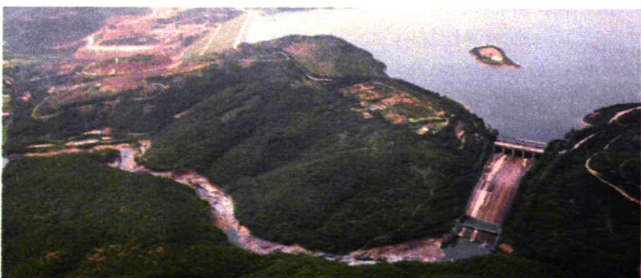
陈家冲溢洪道
