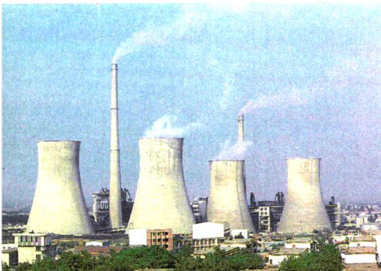
◀ 荆门热电厂一角
