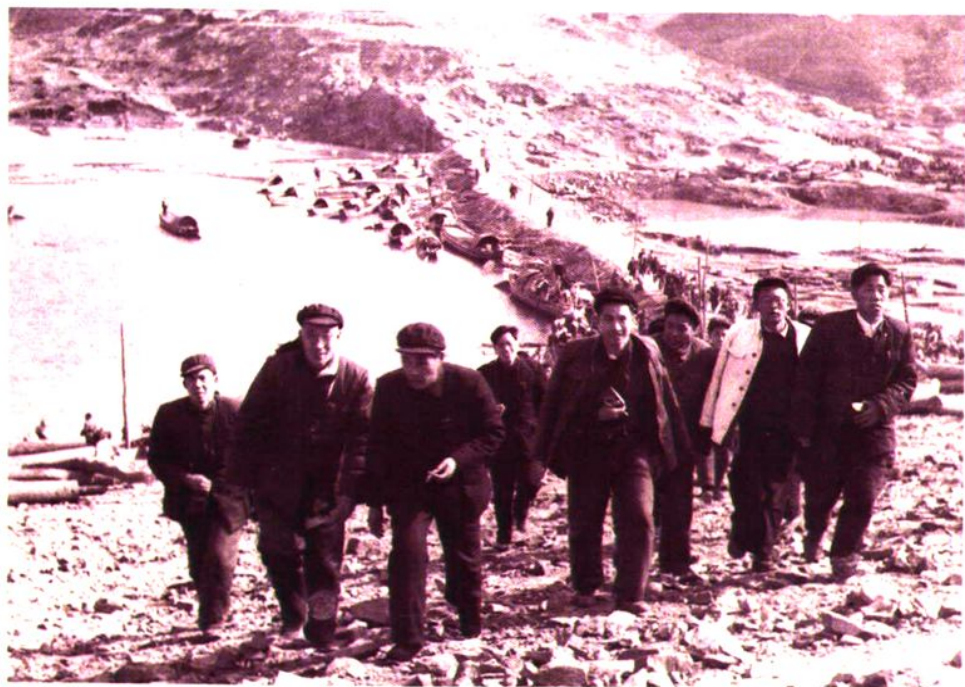
张体学（左三）视察漳河水库工地
