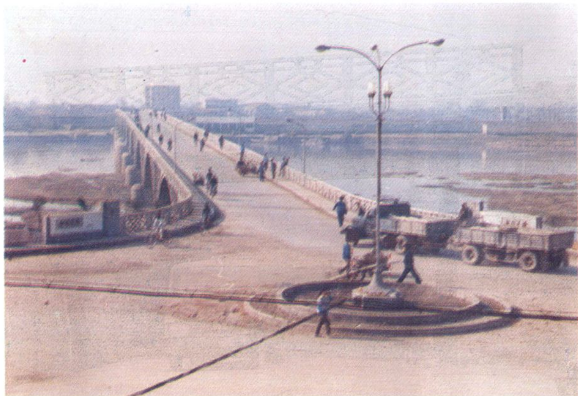
南门公路大桥
