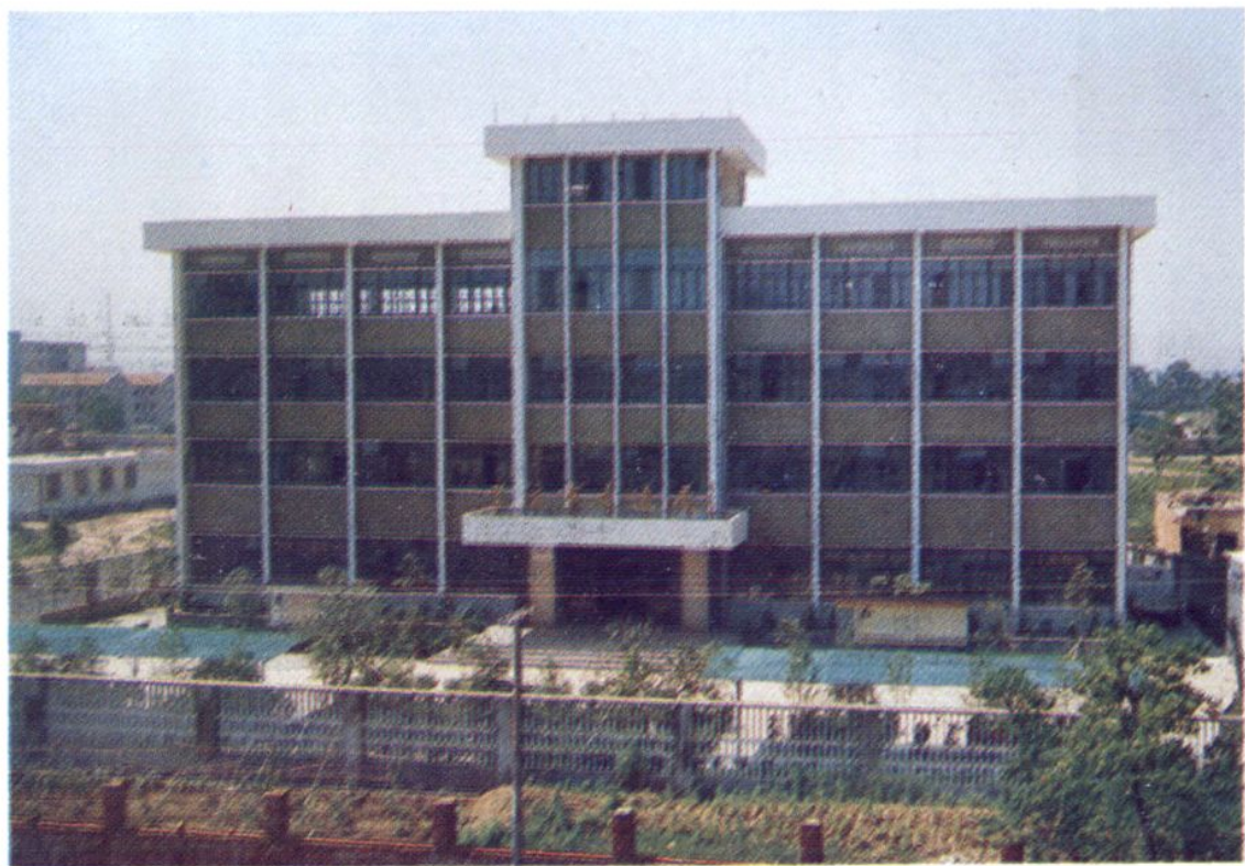
兰溪市交通局办公大楼
