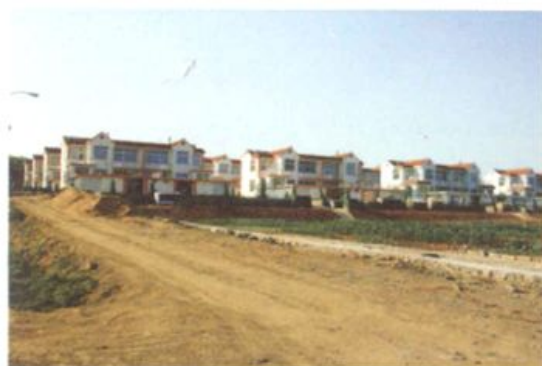
建设中的居民区
