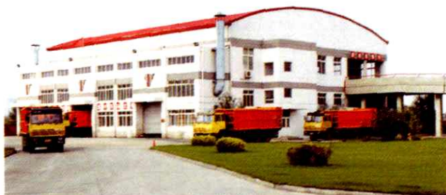
天津市潘楼垃圾处理厂
