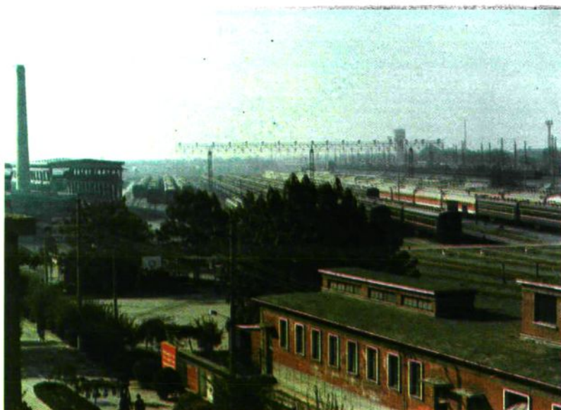
客车技术整备 所停车场全貌
