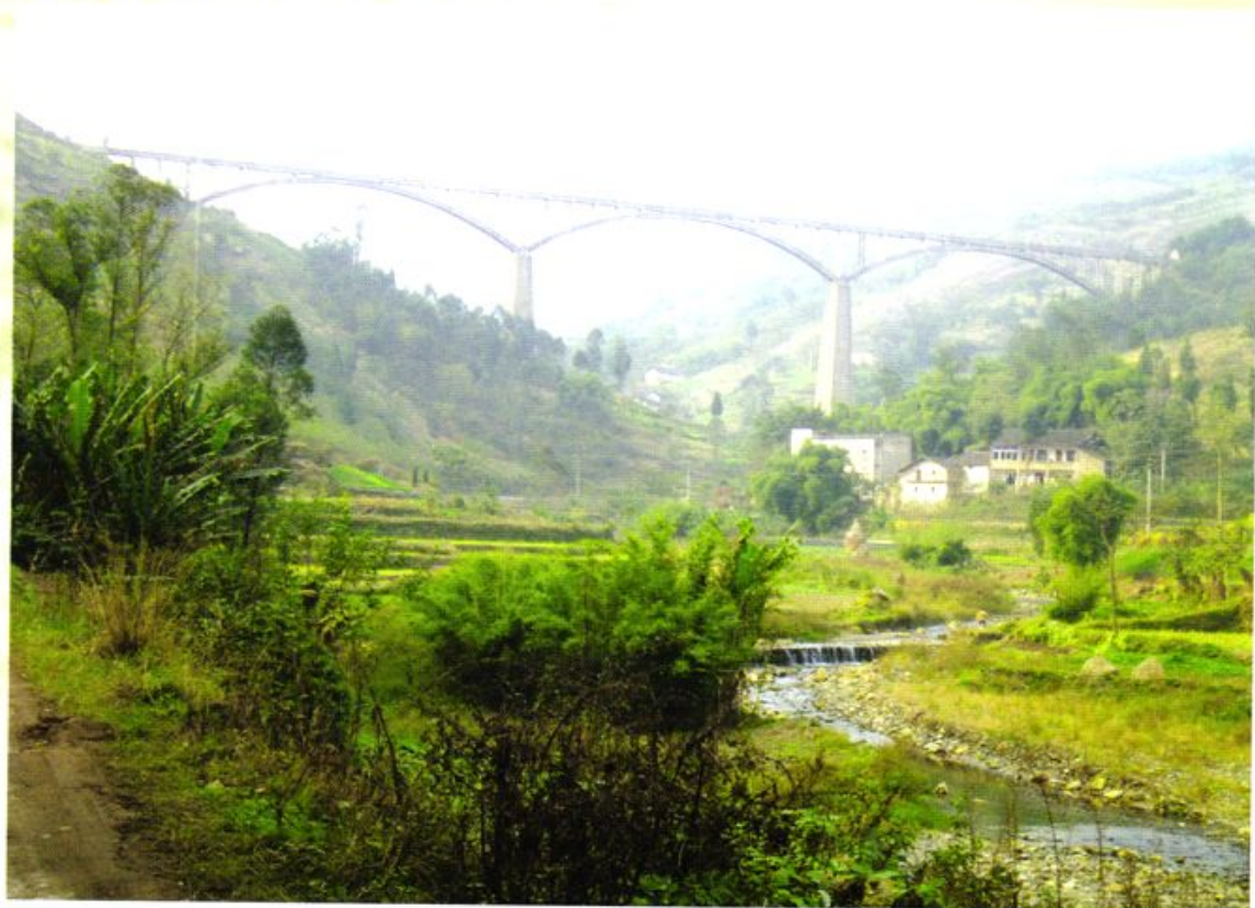
气势宏大的柳荫小桥渡槽
