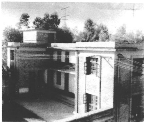
▽县广播站机房引出的广播专线
