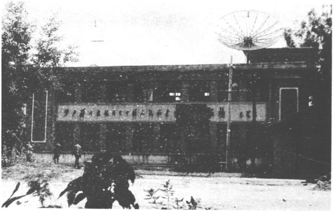
△ 姚安县广播电视局办公楼全景
