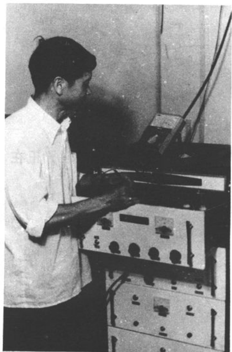
◁县广播站技术人员正在检修100瓦中波发射机
