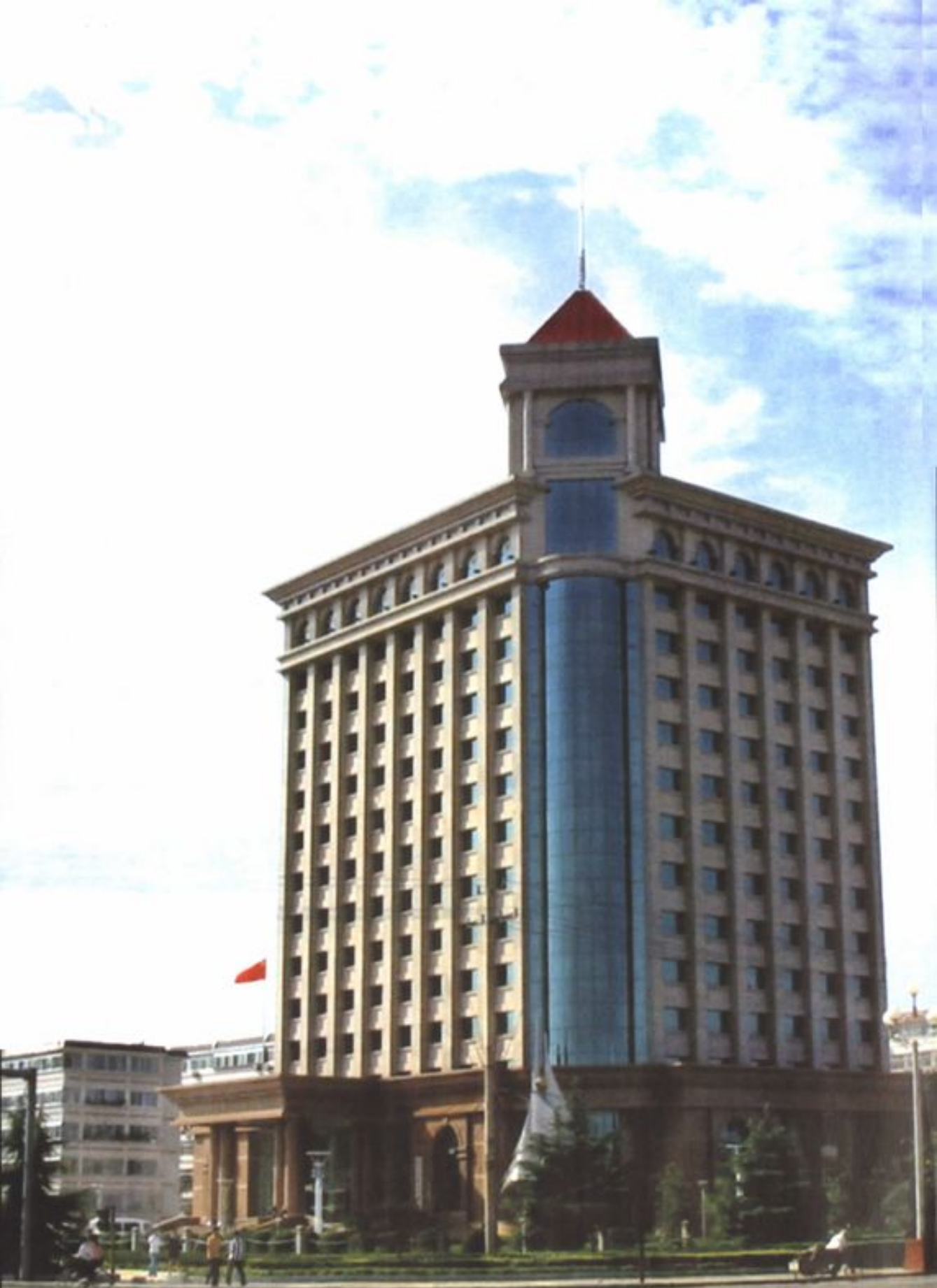
济宁港航通讯大楼
