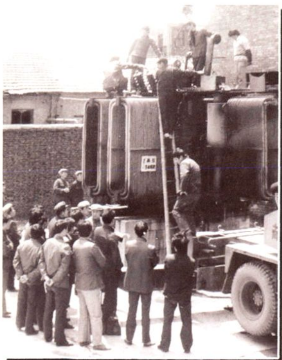
为早日投产，干部、工人正在合力安装变压器
