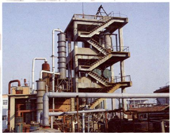
▲ PVC 分厂的 VC 工段及盐酸回收装置
