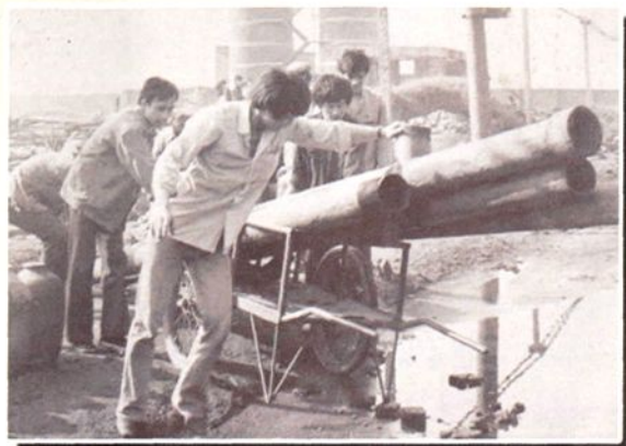
艰苦创业—靠人拉手扛搬运管道设备
