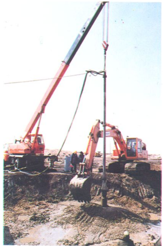
为普阳农场粮食处理中心进行软地基技术处理
