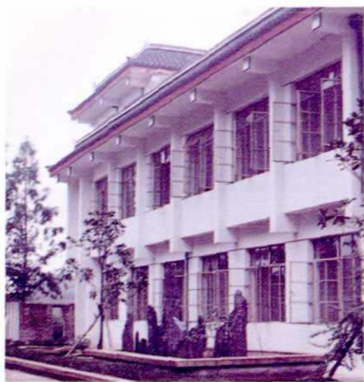
镇医院病房大楼
