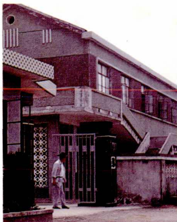
镇电力管理站
