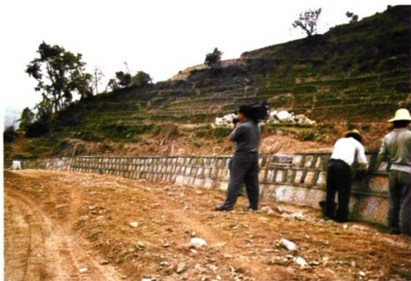
新闻记者在建设工地摄像
