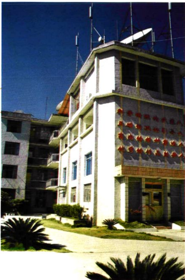
广电局办公大楼
